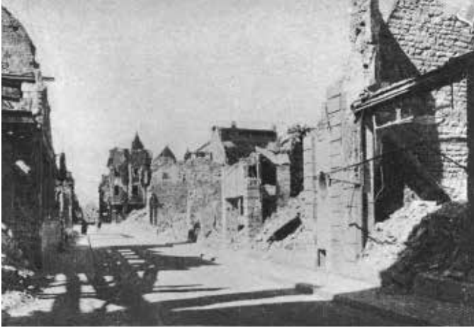
Kämmerer Caddesi: Cehennemi hiçbir ev hasarsız atlatamadı.
